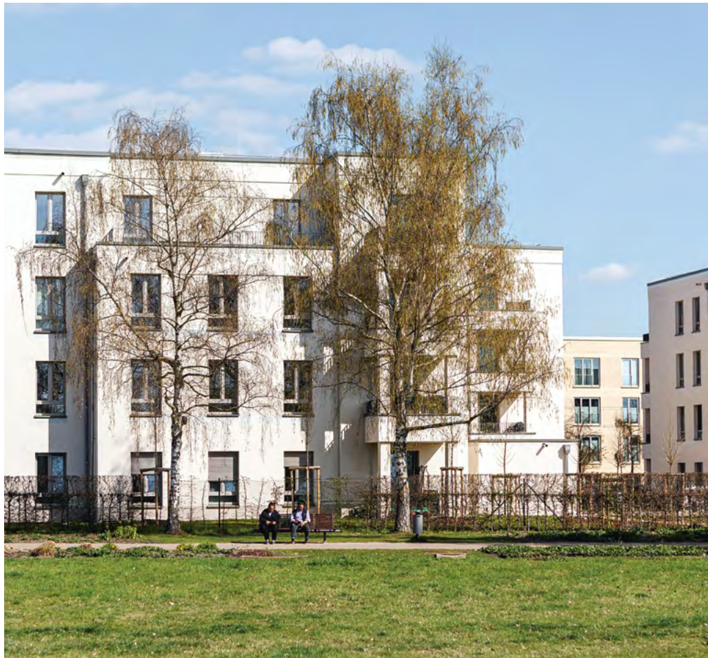
Die Nähe zum Volkspark prägt die besondere Atmosphäre der Wohnanlage.
