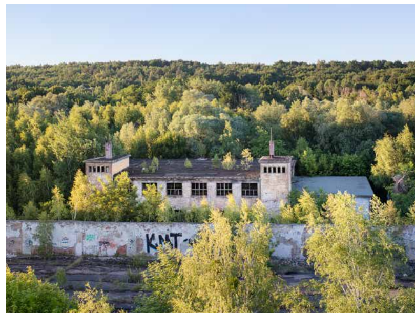
Neunutzung des ehemaligen Heizhauses: Das Herzstück der Energieversorgung bildet das ehemalige Heizhaus im Nordosten von Krampnitz. Dort, wo früher zwei Kohleheizkraftwerke notwendig waren, wird eine innovative Energiezentrale die Versorgung des Quartiers übernehmen.
