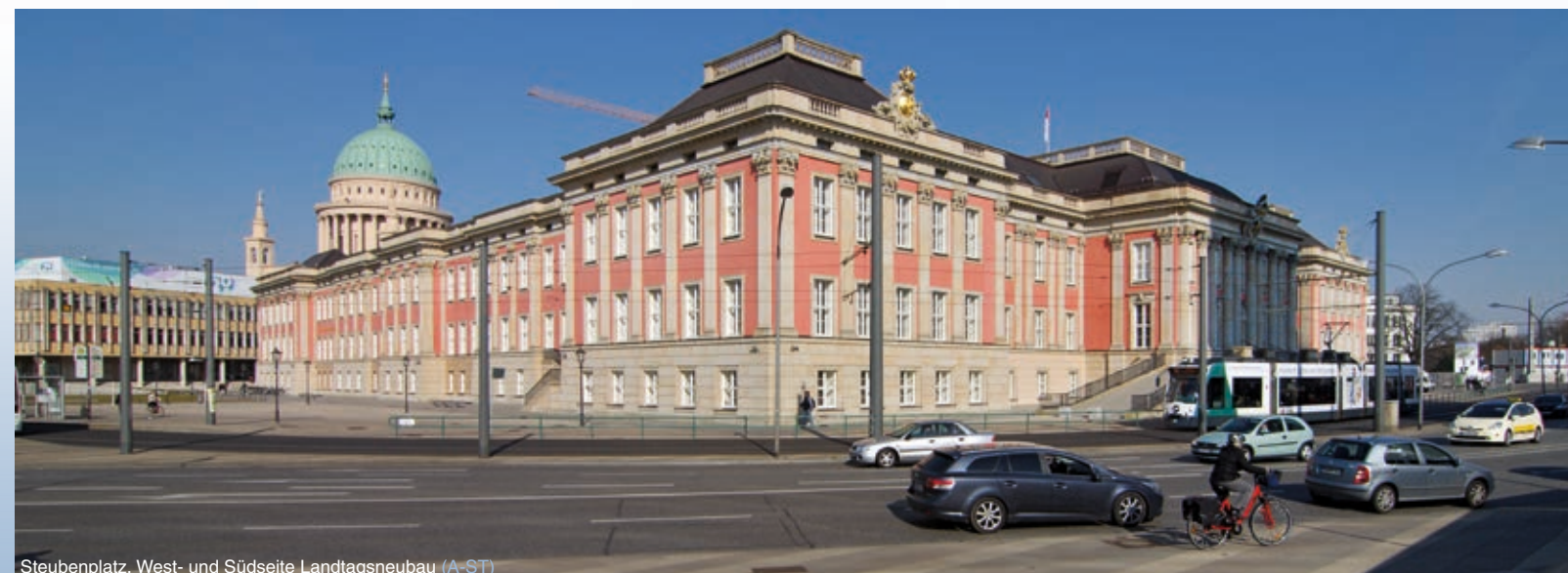
Steubenplatz, West- und Südseite Landtagsneubau (A-ST)
