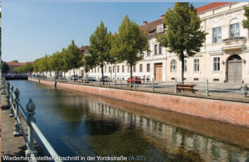
Wiederhergestellter Abschnitt in der Yorckstraße (A-ST)
